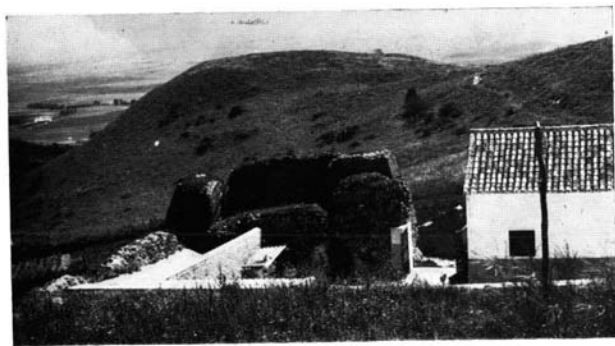
b) Sierra de Gibalbin: puissante construction quadrangulaire en opus caementicium , peut-être une tour de la muraille.
