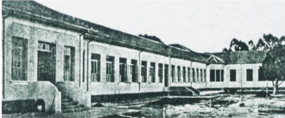
Figura 03: Sanatório Ezra, fachada dos pavilhões femininos e médico-cirúrgico, s.d..
