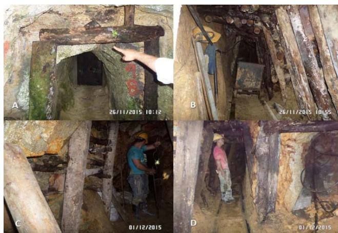
Imagen 4. Escenario de riesgo de colapso del túnel de transporte (ERS-8) Fuente: Propia.
