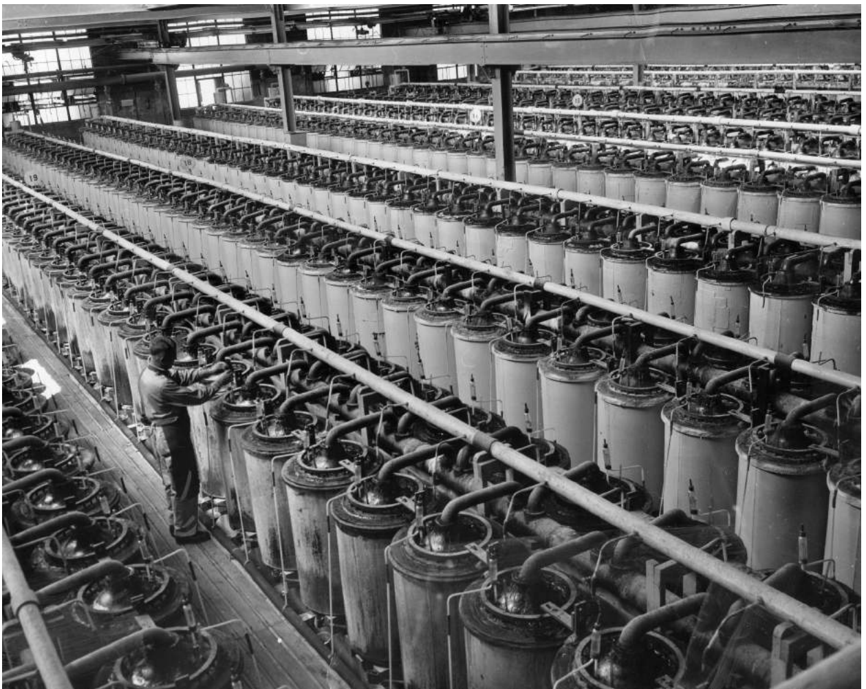
Figura 13. Celdas para electrolisis de cloruro de sodio en la factoría de la empresa The Pennsylvania Salt Co, en Tacoma, Washington (USA), para obtener cloro e hidróxido sódico destinado a la industria papelera. Año 1954. Fotografía de Roy Scully.
