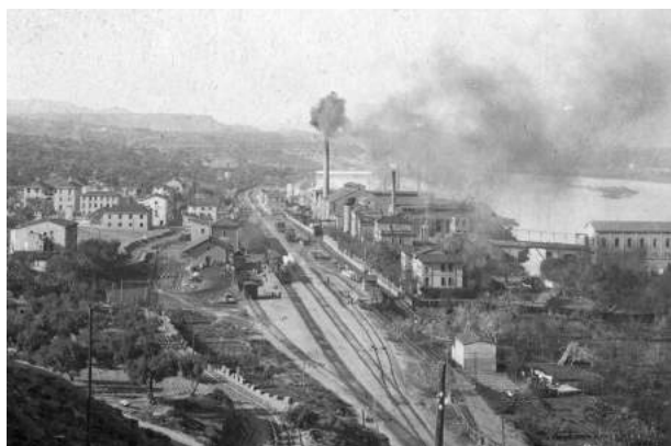
Figura 17. Factoría de la sociedad Electroquímica de Flix. Esta fábrica fue la primera que obtuvo cloro y sosa por electrolisis en España. Hacia 1920. Fotógrafo desconocido.
