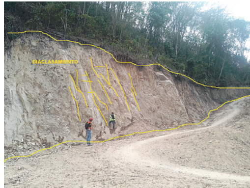
Figura 13. Discontinuidades del segundo afloramiento ubicado sobre la vía que conduce a la vereda La Sierrita
