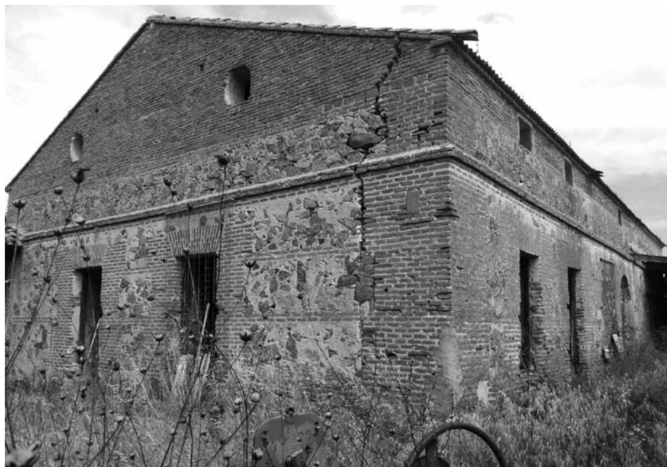
LA CALZADA DE OROPESA. Fábrica de Sayales. Testero sur y fachada interior.
