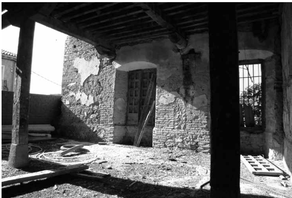
LA CALZADA DE OROPESA. Fábrica de Sayales. Dependencia en planta baja. Ventana y puerta a la Calleja de Enmedio, hoy desaparecida.
