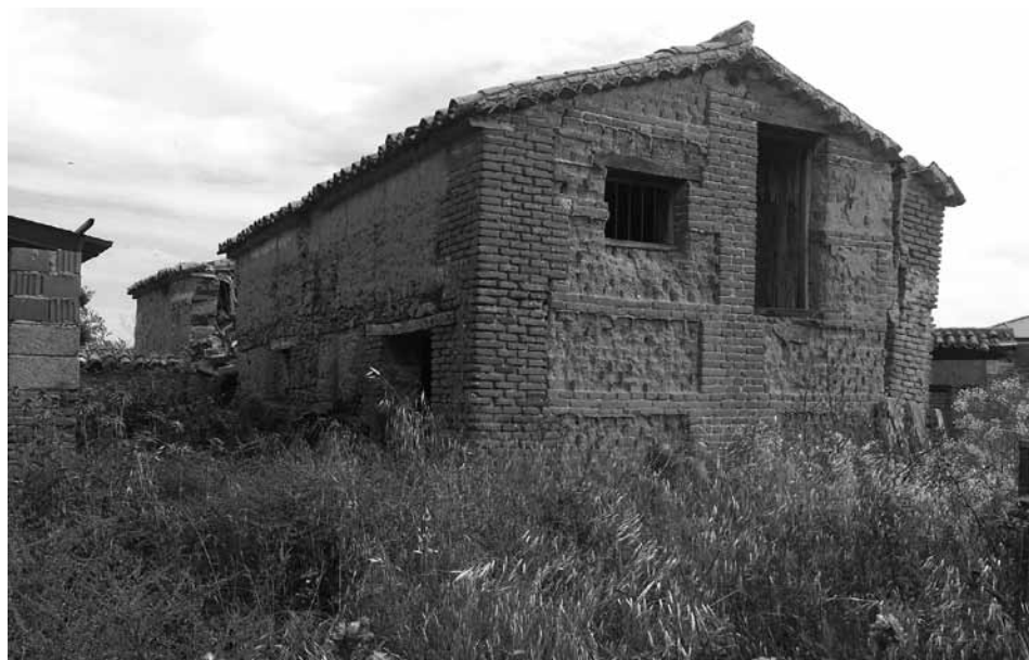
LA CALZADA DE OROPESA. Fábrica de Sayales. Enramada (pl. baja) y pajares (pl. alta) Testero norte y fachada principal.
