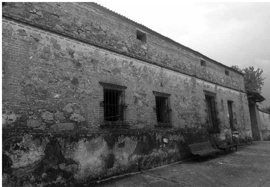
LA CALZADA DE OROPESA. Fábrica de Sayales. Fachada principal. Detalle central.
