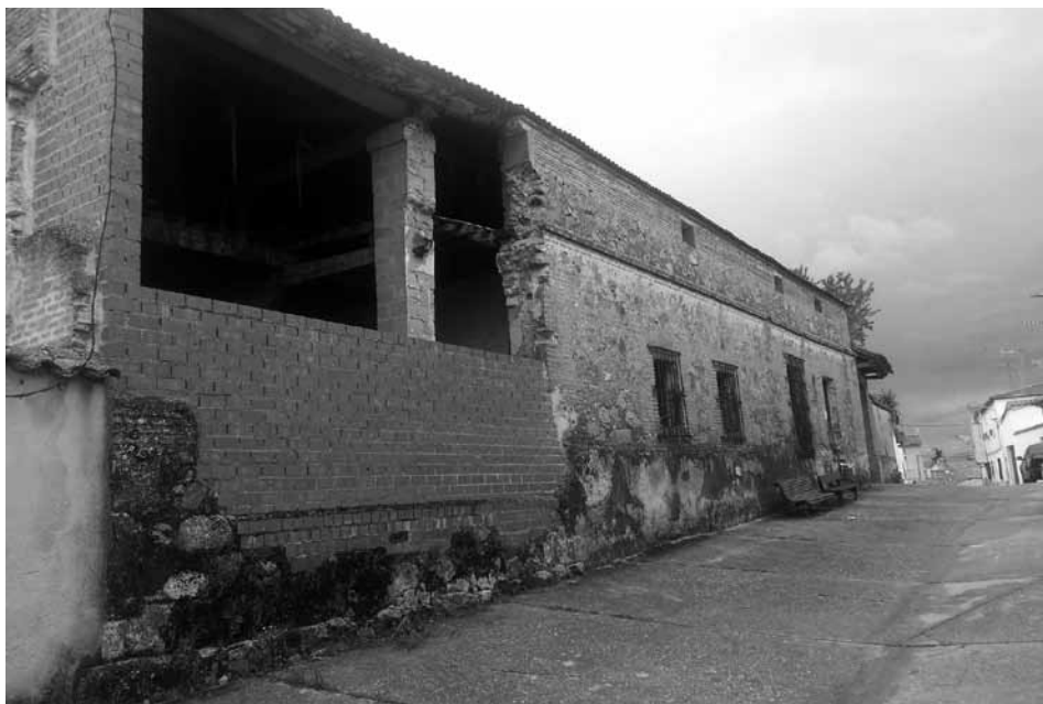
LA CALZADA DE OROPESA. Fábrica de Sayales. Fachada principal desde el norte.
