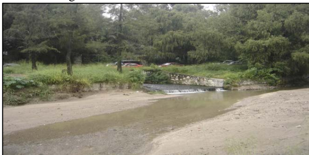
Imagen 6. Tramo Canal Patria-Colomos
