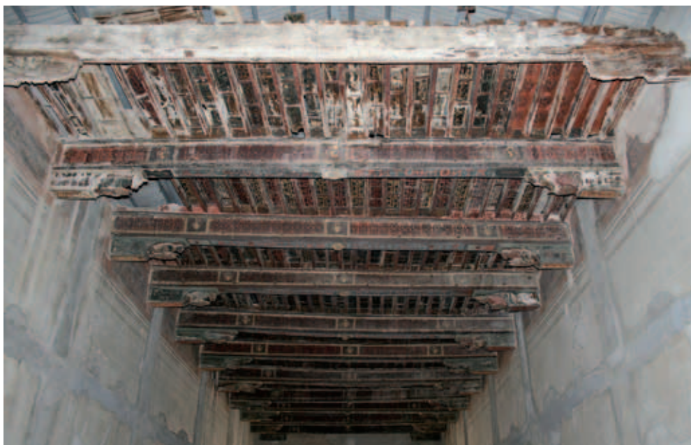
La techumbre del Tanto Monta antes de la restauración. (Foto: José Antonio Tolosa, www.aragonmudejar.com )
