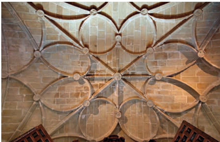
Figura 4. Bóveda del sotacoro de la iglesia conventual. San Millán de la Cogolla. Juan Pérez de Solarte, ca. 1544.
