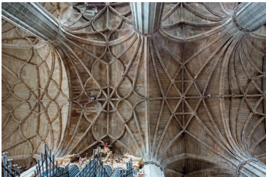
Figura 22. Bóvedas de los tramos de los pies de la iglesia parroquial. Briones. Juan Martínez de Mutio, 1546-1554.
