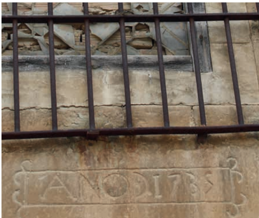
Fig. 1: Iglesia de Santo Tomás, exterior de la capilla mayor.
