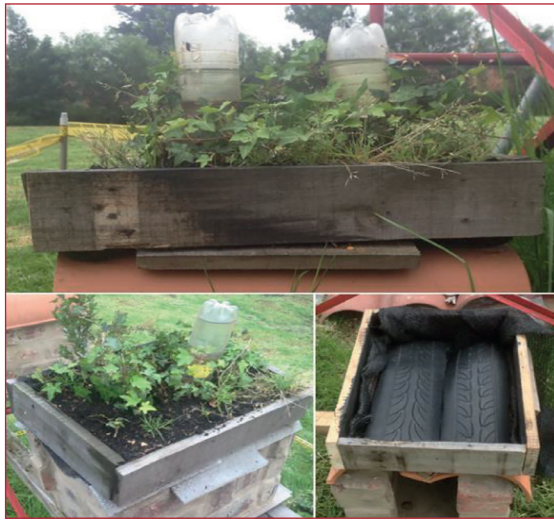
Figura # 4. Montaje y construcción del perfil de techo verde con una profundidad total de 9 cm de la superficie del sustrato hasta la superficie de la teja. Fotografía tomada el 20 de enero de 2017.
