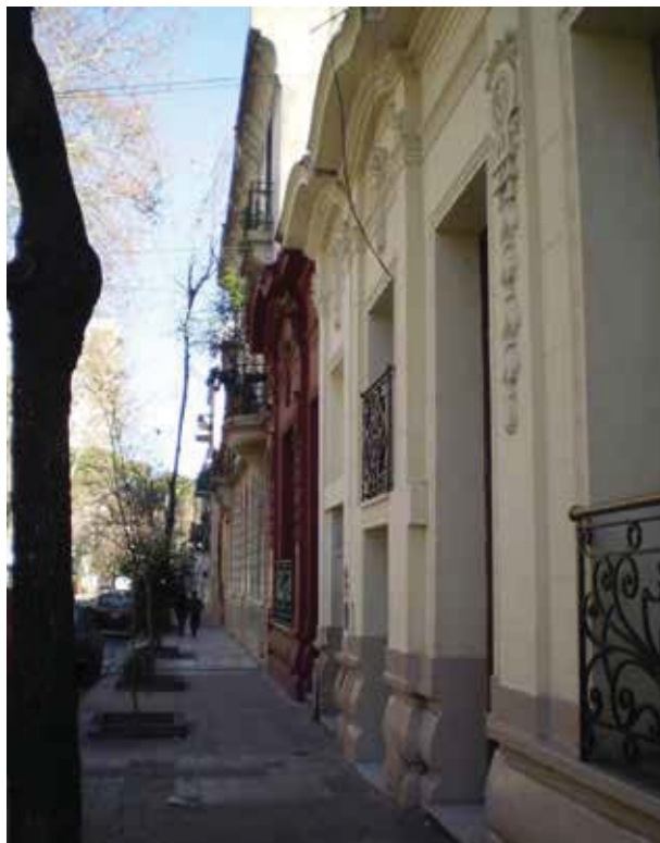
Figura 1: Fachadas de antiguas casas del barrio de Floresta
