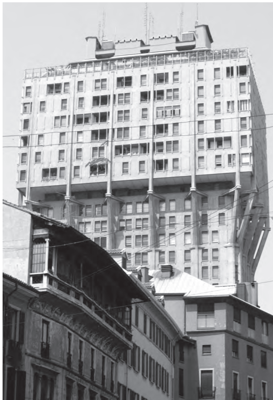
Figura 13. BBPR Torre Velasca. Milán, 1956-1958. Fotografía: Jorge Torres.
