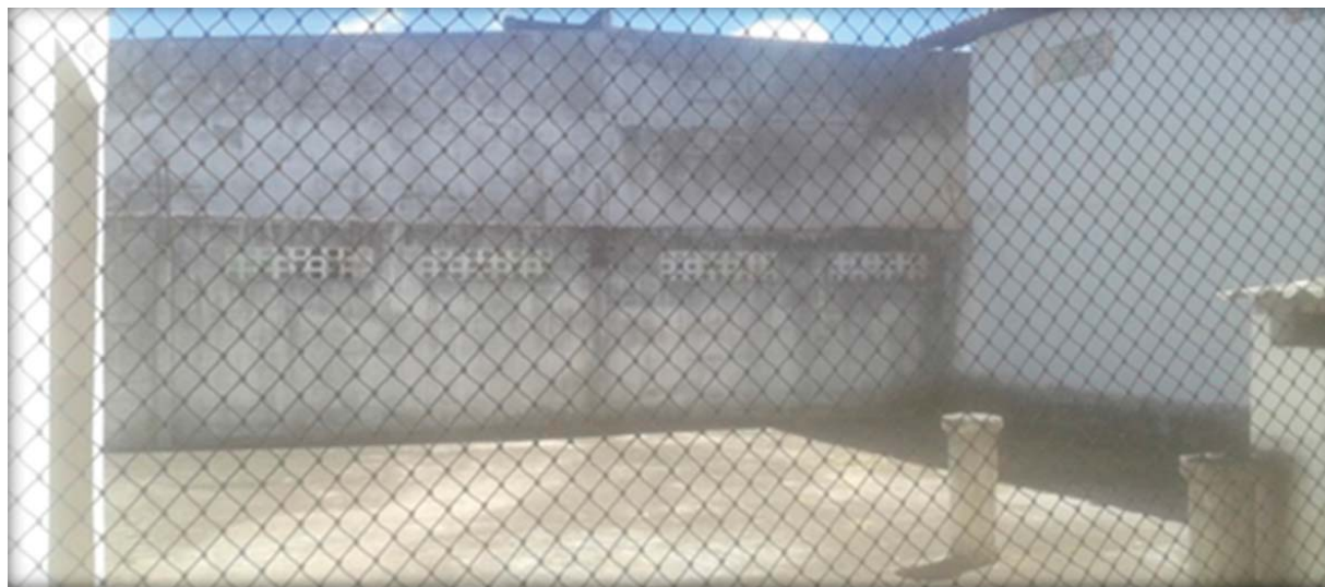
Figura 2- Quadra da escola (antes)
