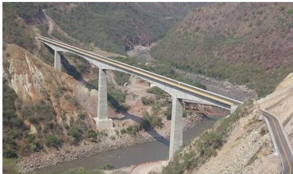
Figura 1. Puente Gómez Ortiz. Fuente: [9].
