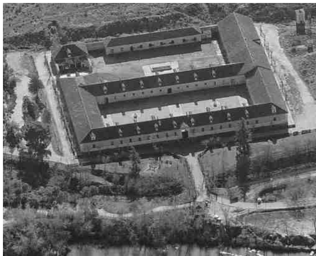
Vista aérea de la Casa de la Monta (Jaime Marquet 1761) en la Finca Sotomayor. Fuente: Fotogrametría Here, 2017 (Buscador Bing).
