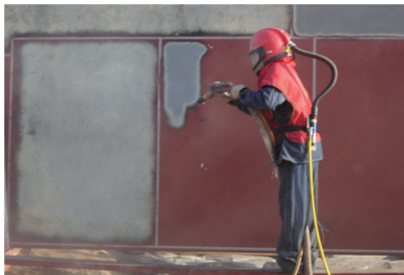
Gráfico 2. Pruebas de campo para la evaluación de productividad y calidad de la preparación de superficie
