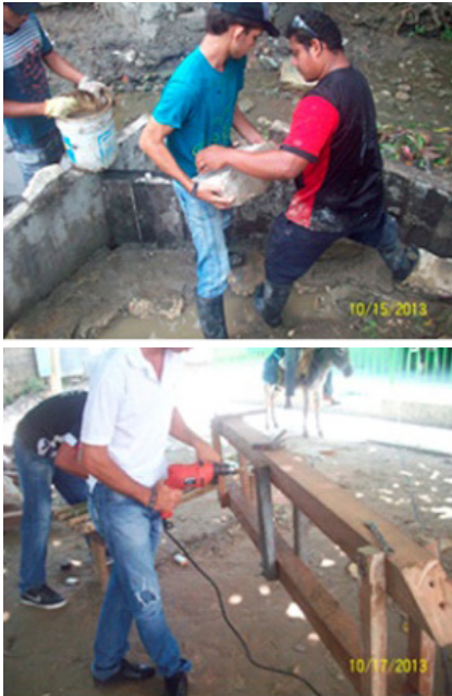
Figura 5: Proceso constructivo con la comunidad. Fuente: El autor, 2013.
