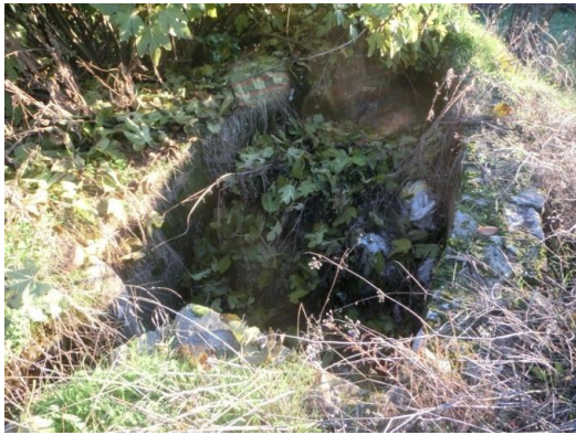
Fig. 8: Vista del Cubo
