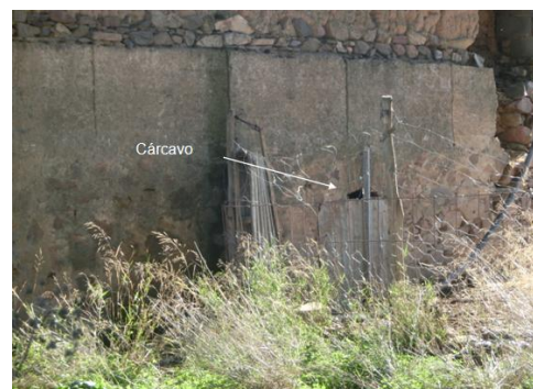
Fig. 43: Vista del cárcavo
