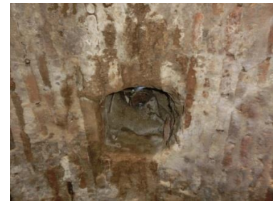
Fig. 20: Ranura del eje
