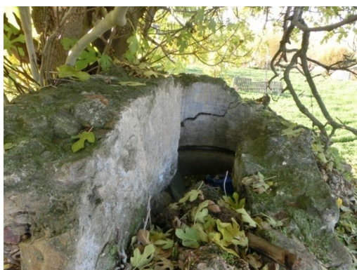
Fig. 6: Vista del Cubo
