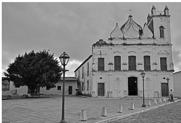
Figura 2 - Igreja Nossa Senhora do Desterro
