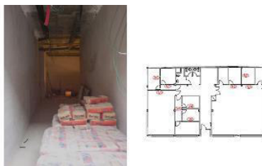
Abb. 18. Eingang zum Bereich für Personenbezogene Dienstleistungen der Stadtverwaltung Sant Quirze del Vallès, Barcelona, Juli 2008.
