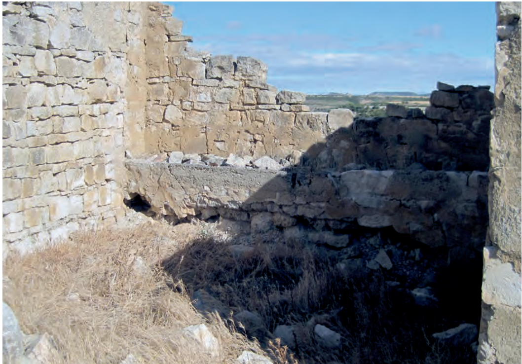
Figura 25. Cabaña de Pío construida en parte con aparejo pseudoisódomo (Txaro Mateo).
