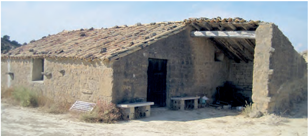
Figura 12. Cabaña de Martín Alfaro construida con sillares y sillarejo (Txaro Mateo).
