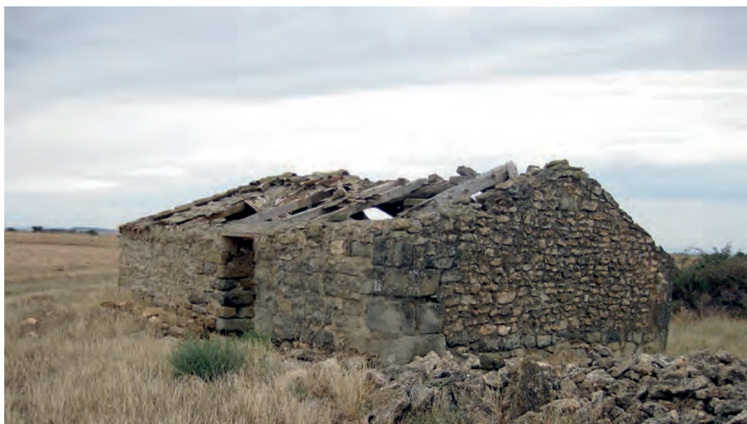
Figuras 26 y 27. Cabañas de Malón y del Zapatero. En sus esquinas se han utilizado piedras de mayor tamaño como refuerzo arquitectónico (Txaro Mateo).
