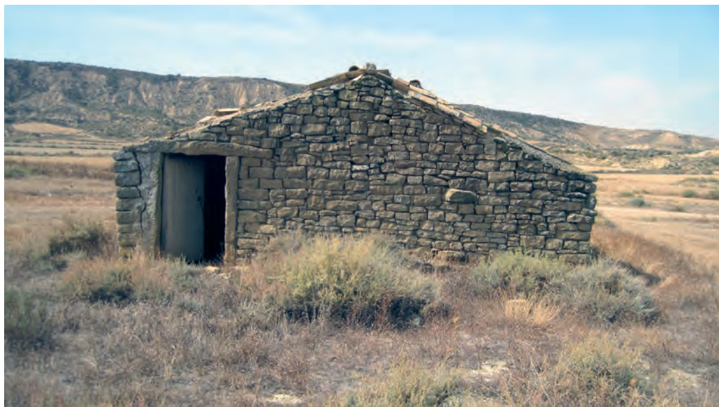
Figura 8. Cabaña del Jota edificada mediante sistema de construcción tradicional (Txaro Mateo).
