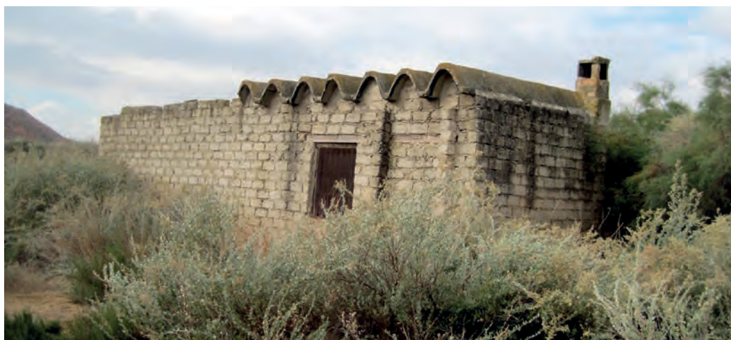
Figura 39. Cabaña de Chueca construida con bloques de hormigón y fibrocemento y cubierta con un curioso tejado ondulado (Txaro Mateo).
