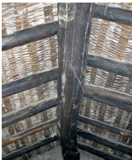
Figura 15. Entramado de la cubierta de la Cabaña de Aguirre a dos aguas (Txaro Mateo).
