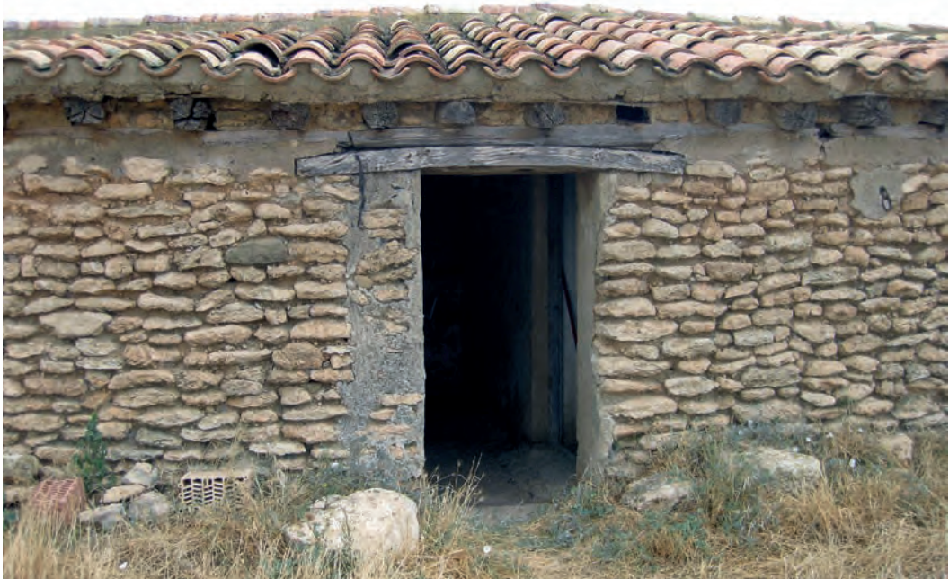
Figura 13. Cabaña de Aicua o del Americano construida con conglomerados cementados (Txaro Mateo).
