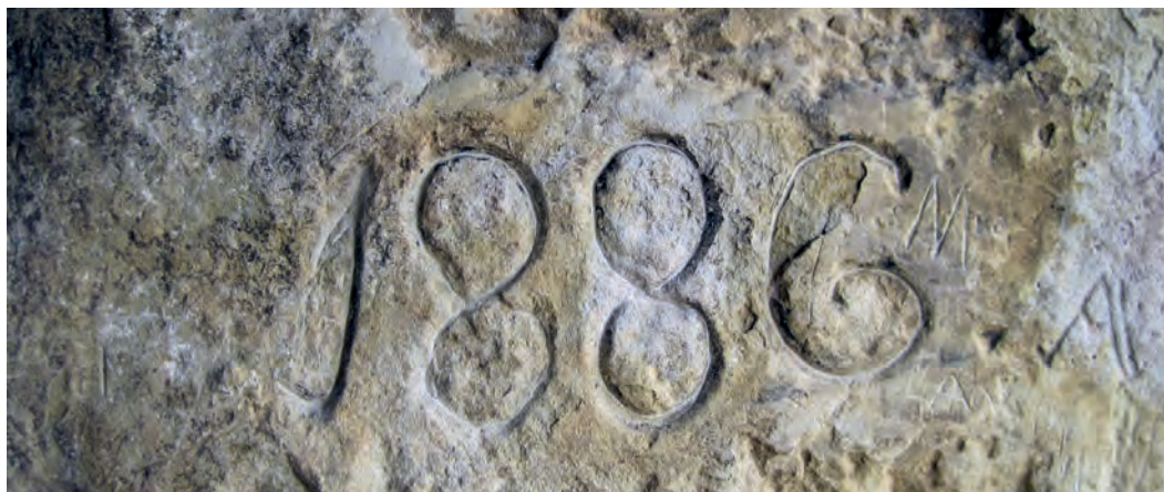
Figura 43. Datación más antigua de construcción sita en la Cabaña de Albajes (Txaro Mateo).
