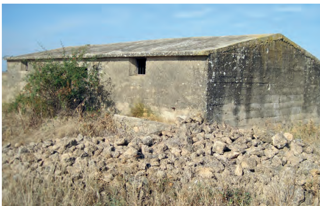
Figura 40. Cabaña del Raboso construida en cemento (Txaro Mateo).
