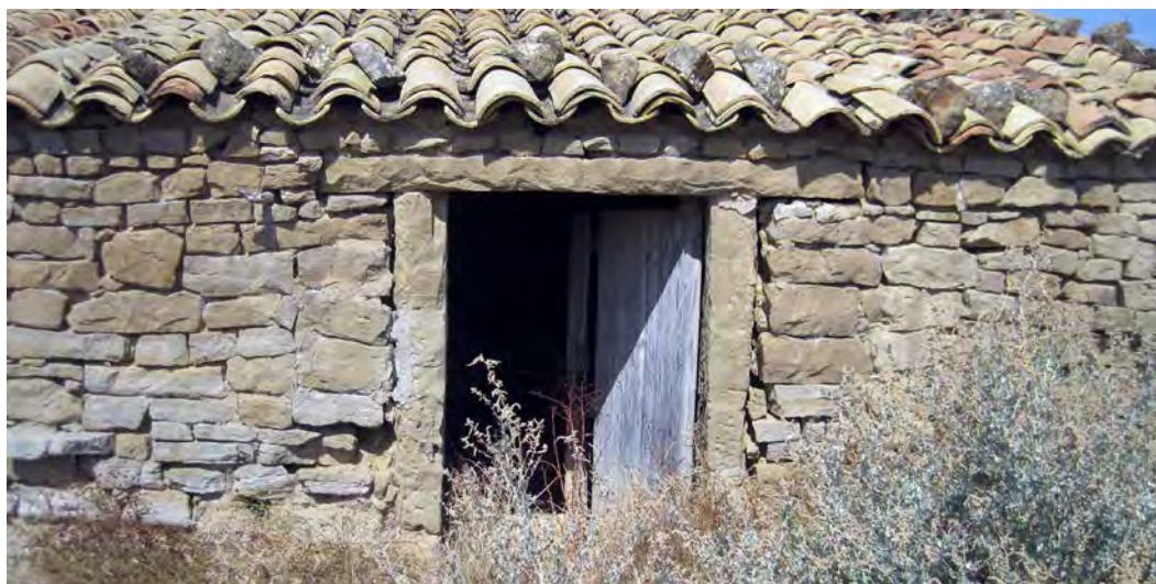
Figura 33. Vano de entrada con losas en la Cabaña de Vicente Echegoyen (Txaro Mateo).
