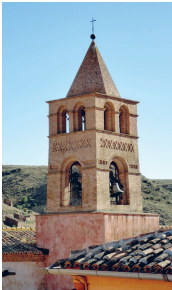
Fig. 11. Cuerpo de campanas añadido a finales del siglo XV a la torre alminar de Huérmeda para convertirlo en campanario.
