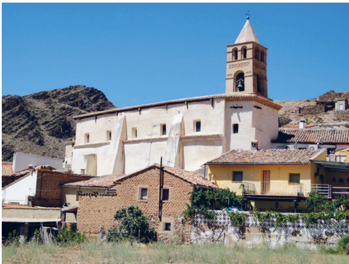
Fig. 12. Vista general de la Iglesia de San Gil de Huérmeda, siglo XV.
