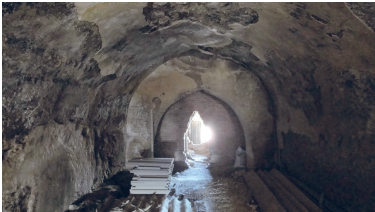
Fig. 4. Interior del criptopórtico del siglo I d. de C. aprovechado como iglesia cristiana, dotado de un arco apuntado que separa la nave del presbiterio (hoy almacén de materiales del yacimiento).
