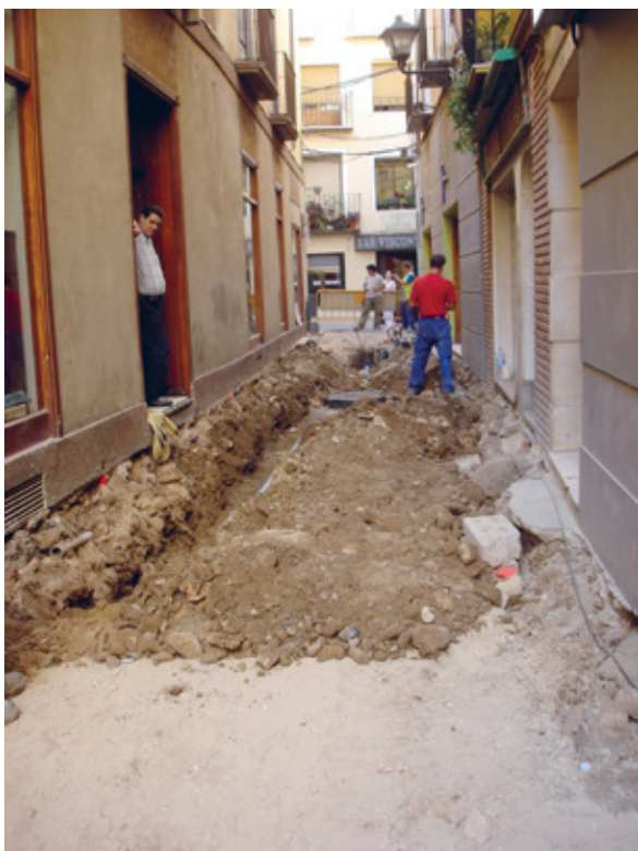
Figura 3. Fotografía de la obra de saneamiento donde aparecieron los materiales arqueológicos.
