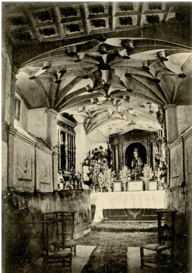
Fig. 16. Fotografía antigua de la Cueva Santa con los abovedamientos realizados a partir de 1545 y eliminados en 1961. Hacia 1915. Colección particular.
