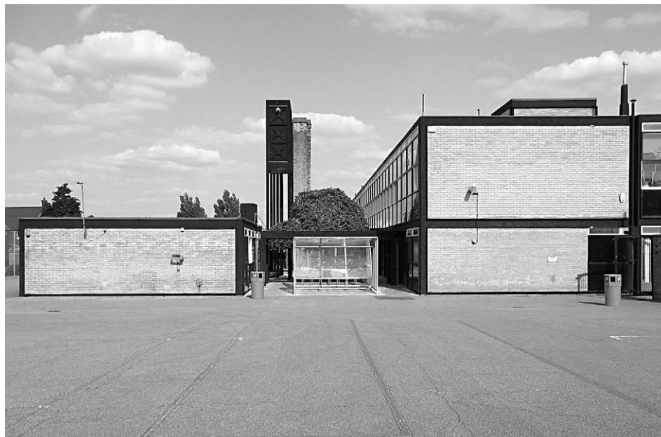
[Fig. 1] Vista oeste de la entrada al edificio principal. Fotografía de la autora, mayo 2009.
