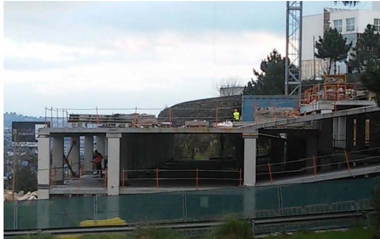
Figura 1. Desarrollo de obra. Acumulación de elementos en un lugar determinado.
