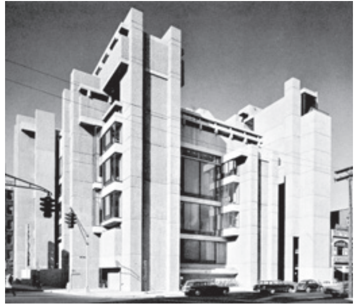
[Fig. 11] Paul Rudolph. Edificio de Arte y Arquitectura de la Universidad de Yale, Connecticut, 1958-1963.
