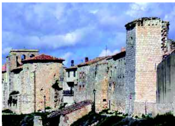
Fig. 3.-Murallas de Haza (Burgos). Costado meridional.
