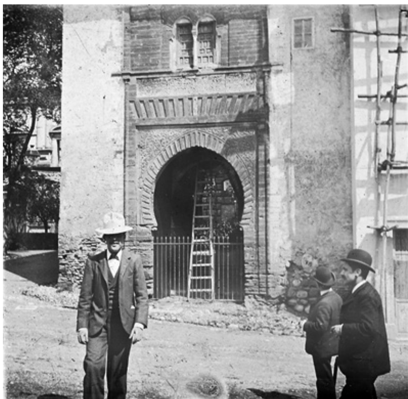
Figura 1.4.4 Fotografía de la portada de poniente, se ven andamios en la casa adosada para enfoscarla (Colección A. Cerdá y Rico).
