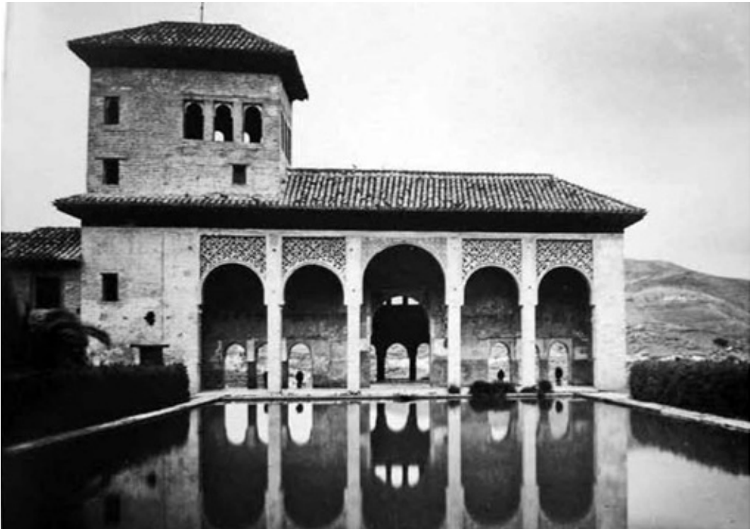
Figura 1.2.5. Fotografía una vez terminada la restauración de Torres Balbas (Fotografía de Torres Molina).
