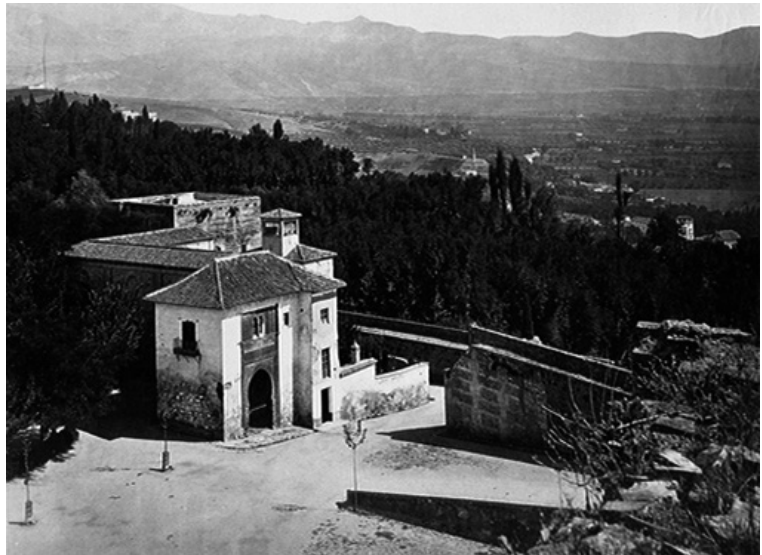
Figura 1.4.1 Fotografía de la Puerta del Vino, portada de poniente, antes de la restauración (Anónima).
