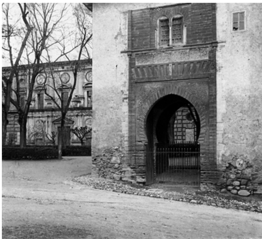
Figura 1.4.3 Fotografía de la portada de poniente, se puede ver el deterioro de la parte baja de la puerta y el enfoscado de la misma (Colección A. Cerdá y Rico).
