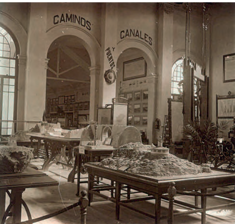
Figura 3. Exposición Regional de Valencia (1909). Interior de uno de los pabellones expositivos dedicado a las ingenierías de caminos, puertos y canales. Archivo Documental Técnico-MARQ.
