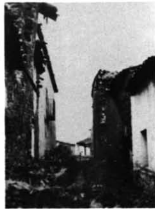
Calle de Granadilla en su situación actual.
