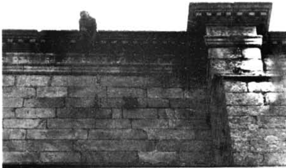
3. Remate exterior, con cruces y arquillos, de Torre de Don Miguel.
