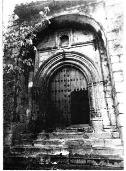
2. Puerta meridional de Torre de Don Miguel.
