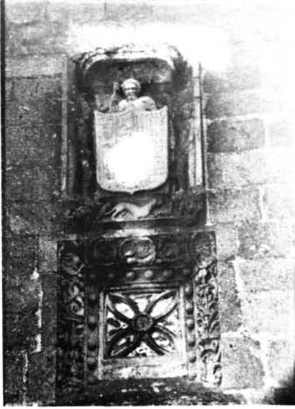
1. Vano sobre la portada Norte de Gata.
