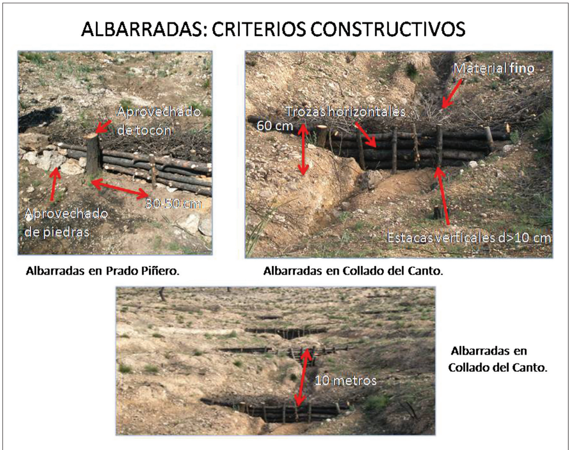
Figura 3. Albarradas. Criterios constructivos (d=diámetro estacas).
