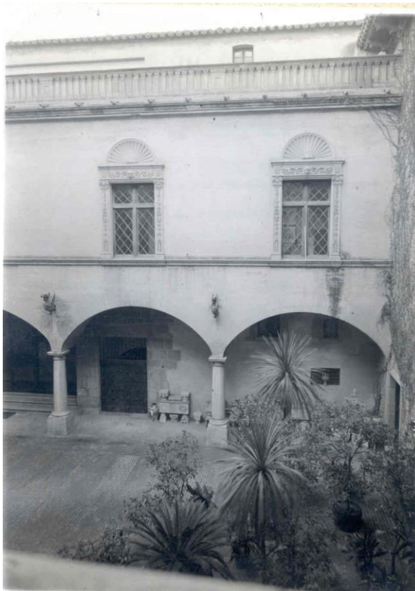
Fig. 7. Patio de honor. Ala norte. El segundo piso se mantiene retrasado, y todavía no dispone de alerón (c. 1925)
