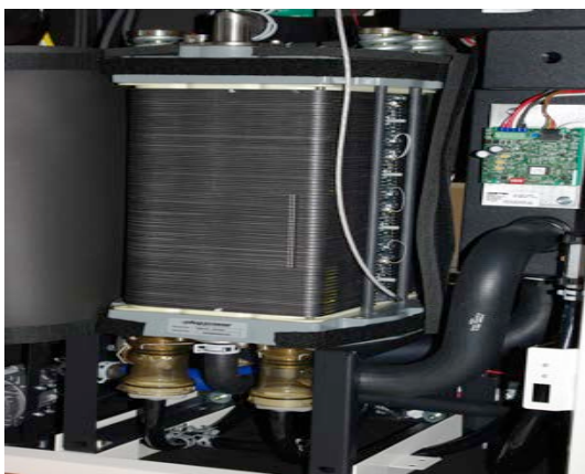
Figura 15. Almacenamiento e inertización.
