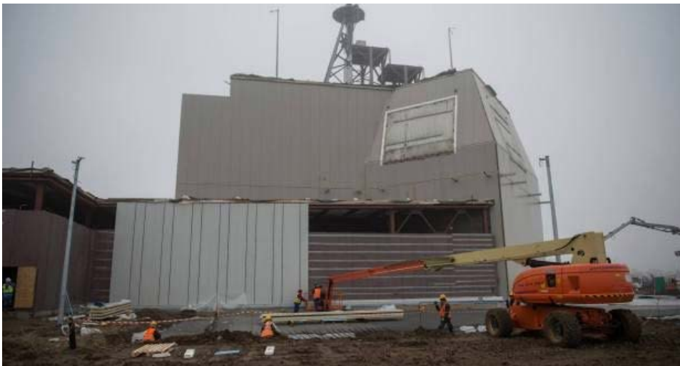
Figura 2: Construcción del sistema antimisil Aegis en Rumanía
