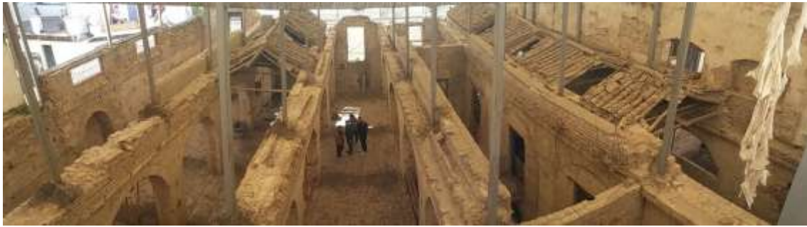
Figura 2: Panorámica de las naves de la planta primera del Pósito de la Corredera en su estado actual. Fotografía del autor.
