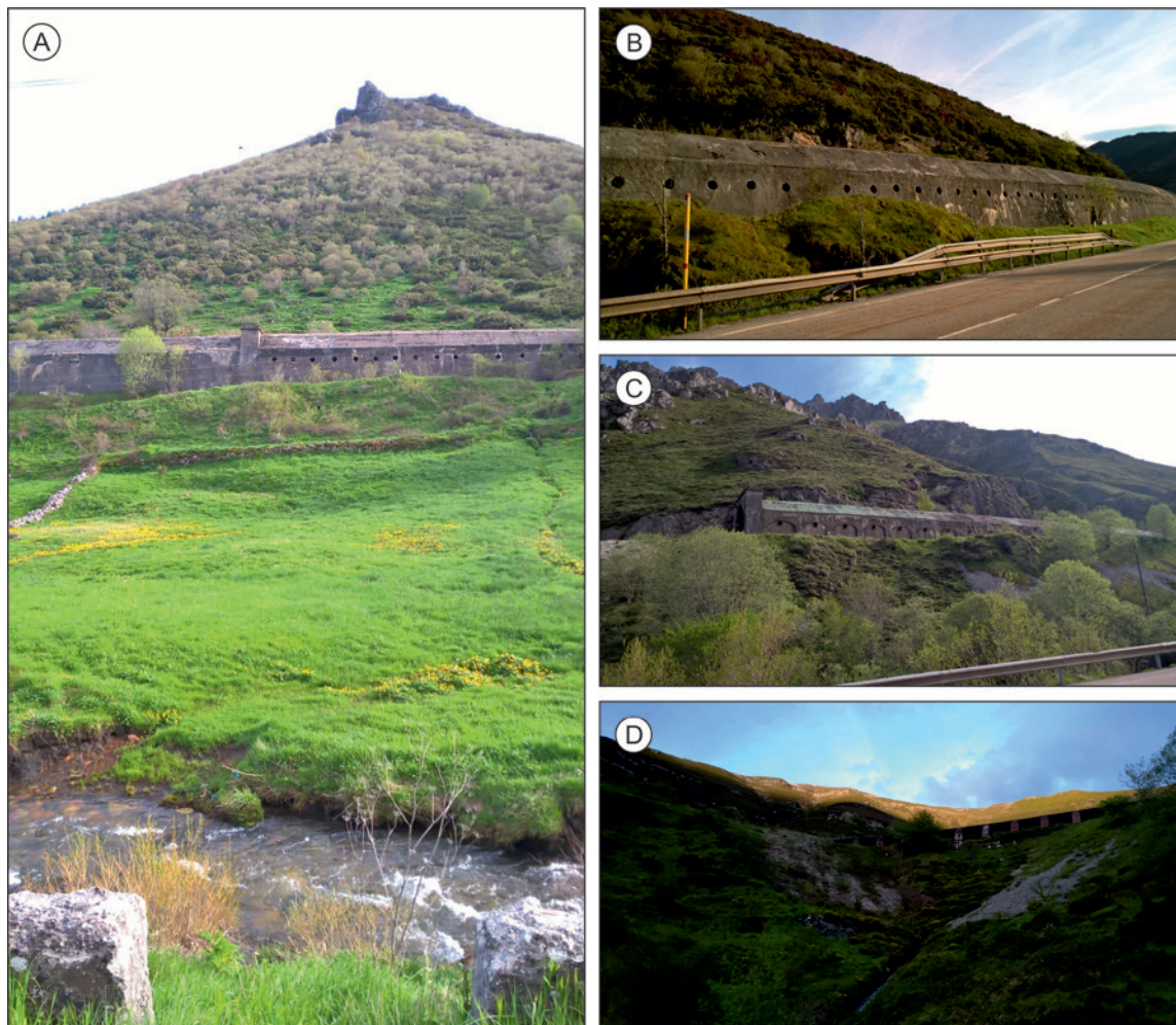
Imagen 5. A) En las inmediaciones de este punto han sido varios los trenes alcanzados por avalanchas. Uno de ellos llegó a precipitarse al río Bernesga. B; C; D) Diferentes tipologías de estructuras protectoras frente a los aludes.
