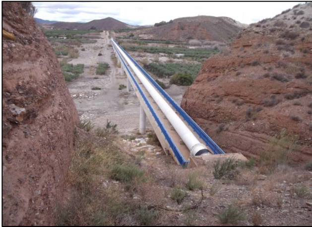
Imagen 3. Acueducto de la Conexión Negratín-Almanzora (C N-A), que atraviesa el Almanzora cerca de Purchena
