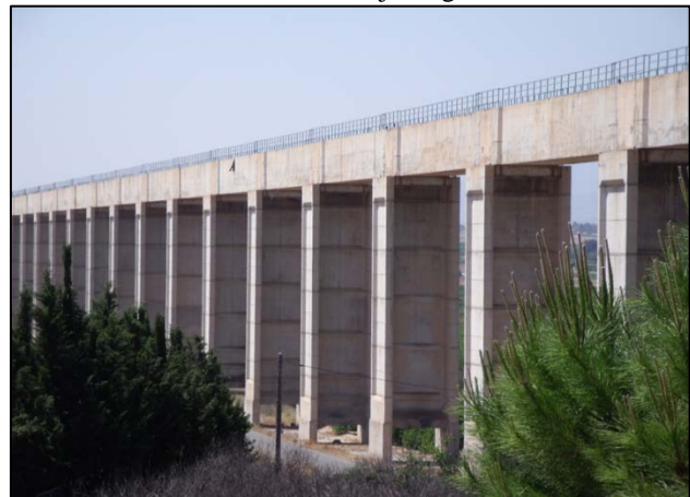
Imagen 1. Acueducto de La Matanza en la red del Postravase Tajo-Segura
