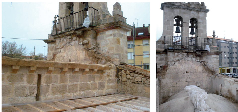
Fig. 8. Aspecto general de la nave central medieval de la ermita de los Remedios durante su restauración en 2010. Foto: Proyecto Cultural Zamora Románica.
