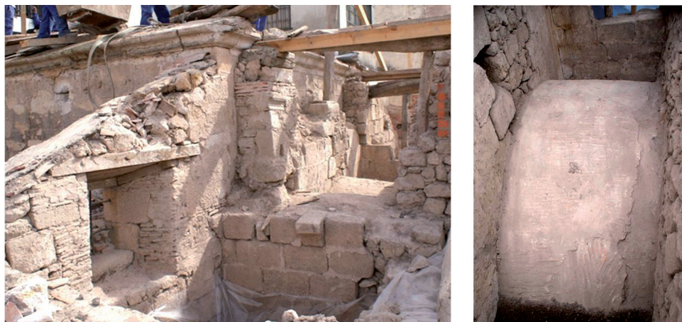
Fig. 4. Restos del ábside medieval durante las obras de restauración. Este espacio se cubrió con una bóveda de ladrillo a tabla cuyos restos aun voltean por encima del retablo actual.
