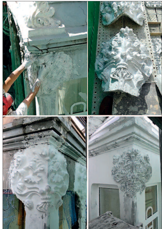
(Figura 5) Toma de moldura con escayola y esparto. Proceso de reconstrucción.
