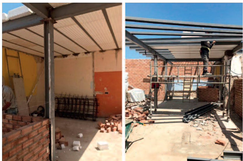
(Figura 15) Estructura sustituida por elementos nuevos y ligeros.
