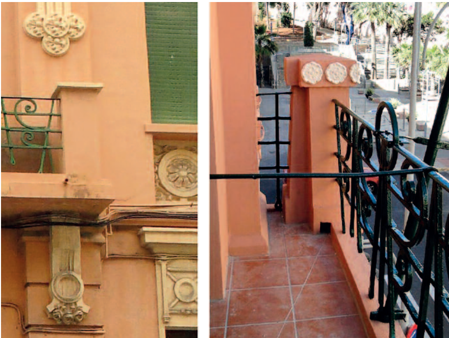
(Figura 12) Reconstrucción de pilastra de bancón.
