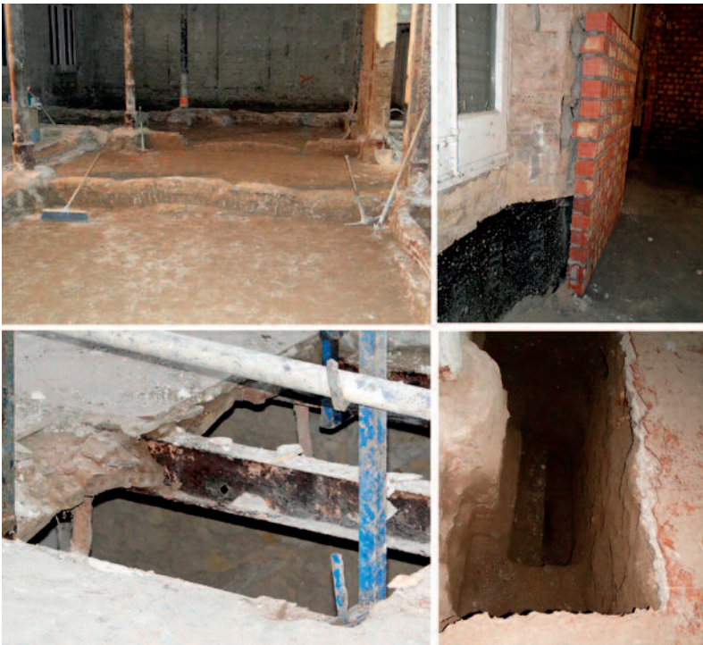
(Figura 9) Refuerzo en cimentaciones y muros.
