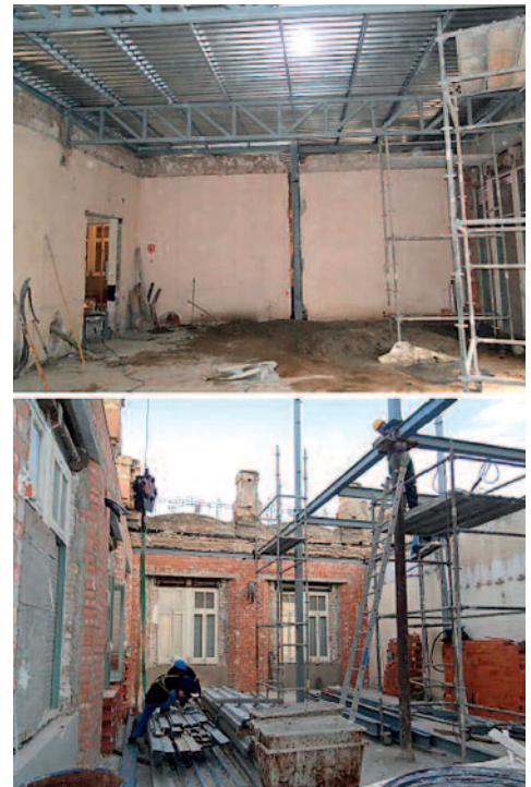
(Figura 10) Estructura ampliada. Cubierta ligera.
