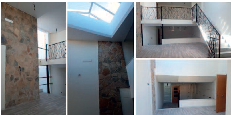
(Figura 20) Acabados interiores. Viviendas 'loft'.
