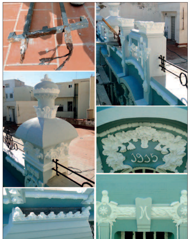
(Figura 6) Cerrajerías y acabados. Aplastillado de fachada.
