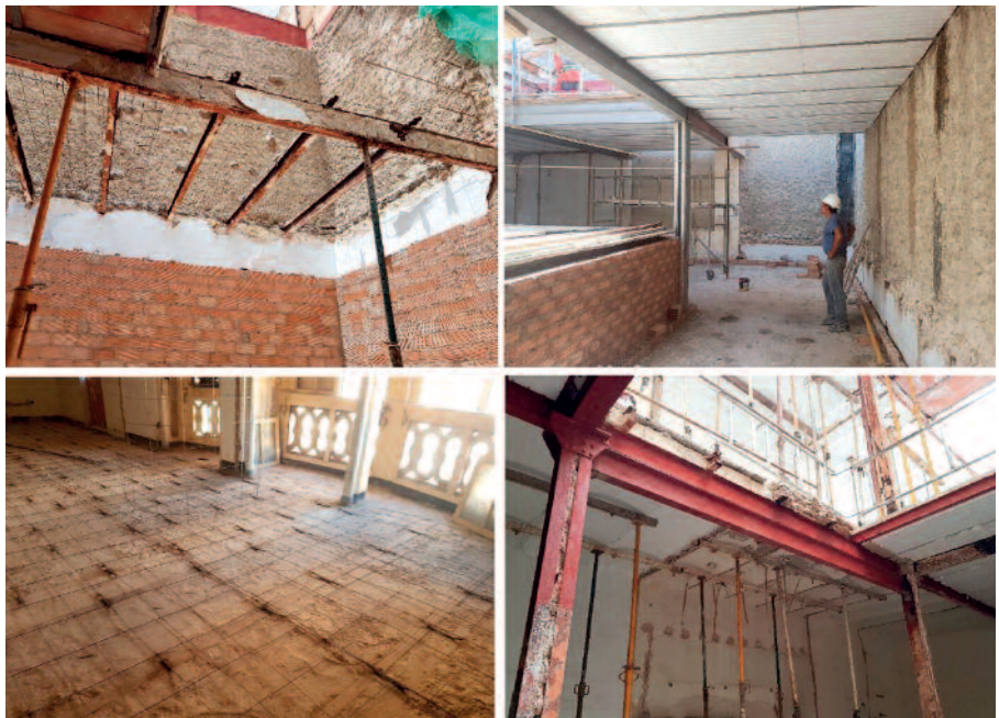
(Figura 19) Forjados rehabilitados.
