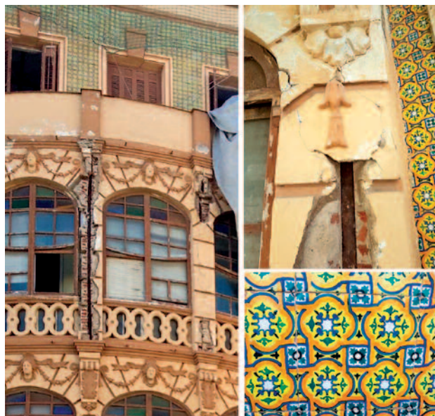
(Figura 22) Reparaciones en fachada. Recuperación de alicatados decorativos.
