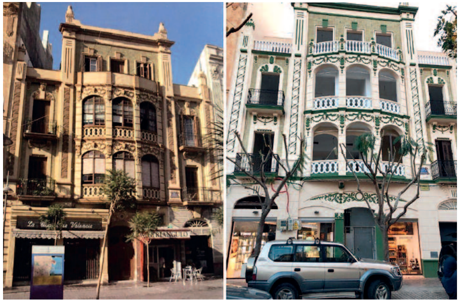
(Figura 18) Fachada del edificio en proceso de rehabilitación.
