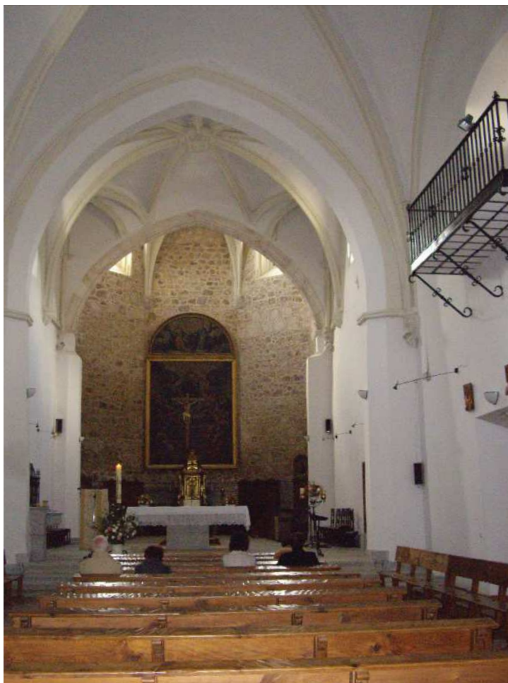
Fig. 2. Interior de la iglesia del monasterio de Monte Sión, Toledo.
