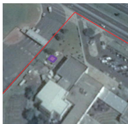
Figura 11. Área del CEA (Rojo) - emplazamiento propuesto CEILOMETER CT 12K (Violeta)- Vista Norte Real
