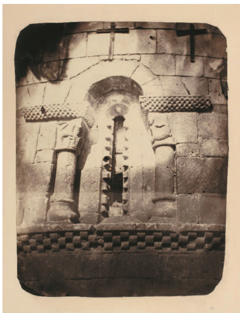
Figura 6. Estado de la portada de la iglesia antes de su restauración. 1868. RABASE, Archivo-biblioteca, Fotografías, caja 27, exp. 287, fot. 2164.
