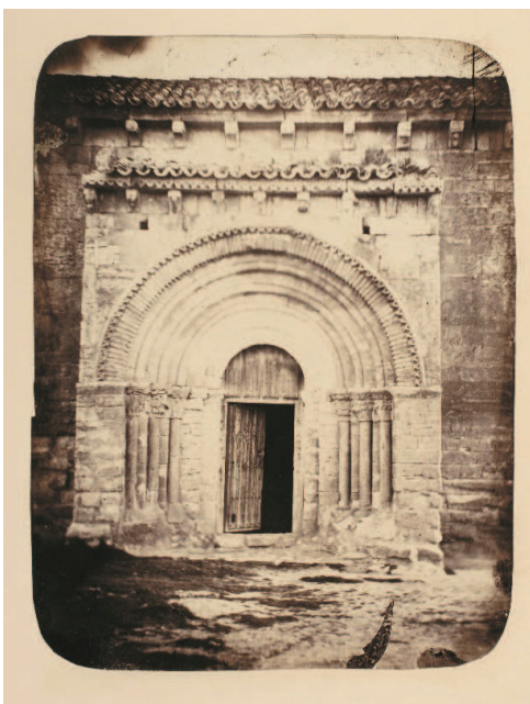
Figura 7. Estado de una de las ventanas del ábside de la iglesia antes de su restauración. 1868. RABASE, Archivo-biblioteca, Fotografías, caja 27, exp. 287, fot. 2165.
