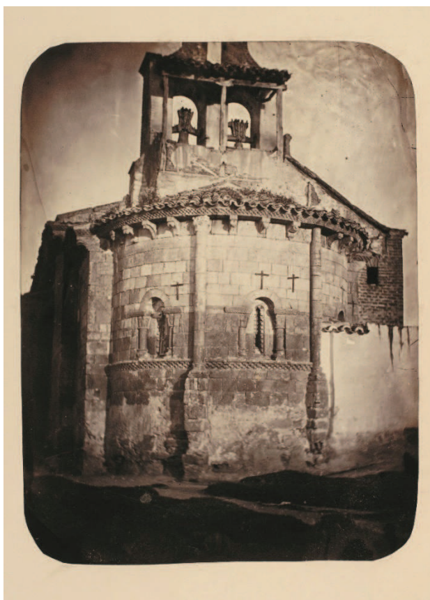
Figura 4. Estado del ábside, espadaña y construcción de ladrillo adosada al lado norte antes de la restauración de la iglesia. 1868. RABASF, Archivo-biblioteca, Fotografías, caja 27, exp. 287, fot. 2162.
