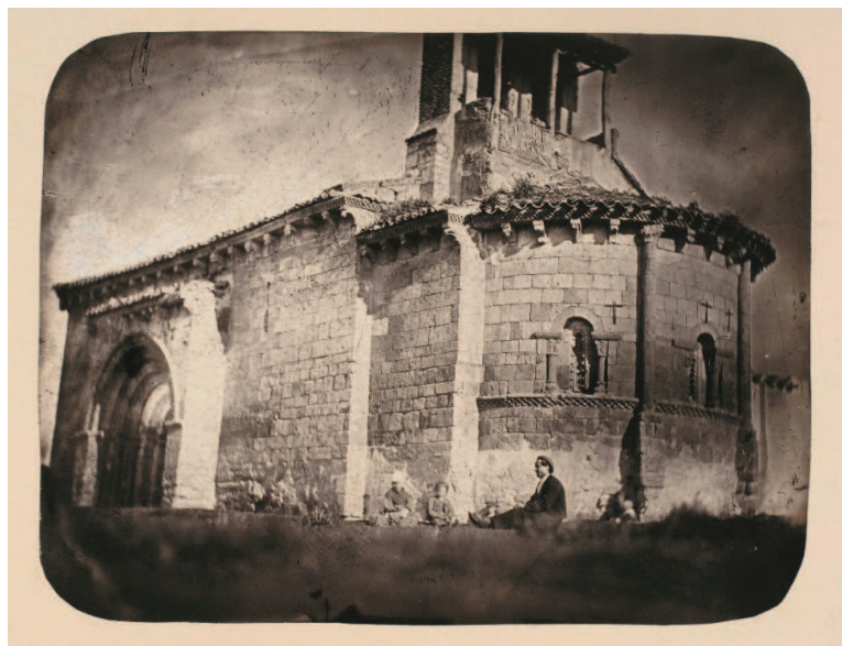
Figura 5. Vista general del estado de la iglesia antes de su restauración. 1868. RABASE, Archivo-biblioteca, Fotografías, caja 27, exp. 287, fot. 2163.
