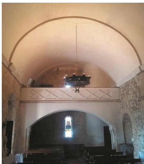
Figura 11. Estado actual del coro y bóveda tabicada de la iglesia. Elaboración del autor.
