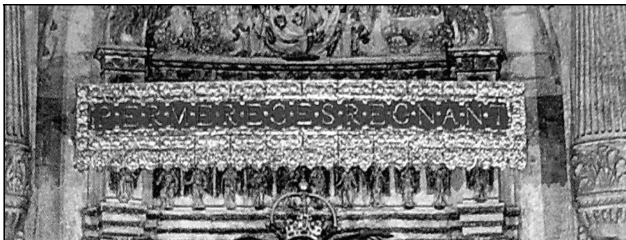
1. Gotera del S. XVIII de la Capilla Real de Sevilla.
