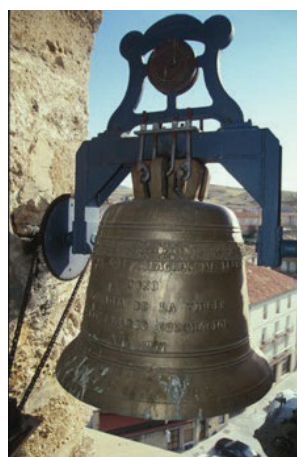
Campana de la torre izquierda. Nombre: Virgen de los Milagros 267 kilos. Diámetro 89 cm. Año de fundición: 1997
