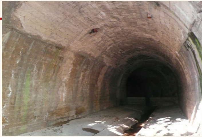
Tramo final del túnel
