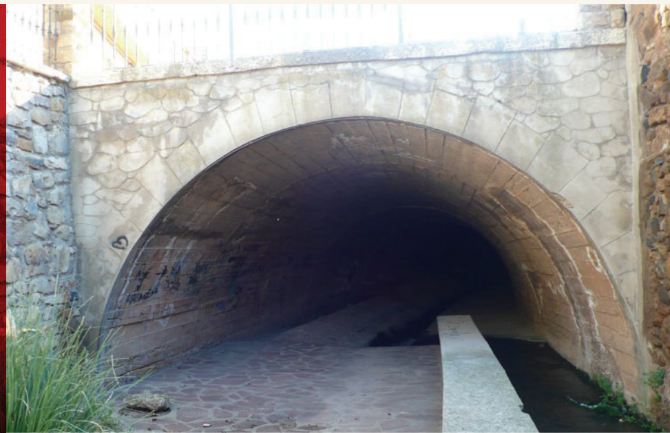
Bóveda bajo el Puente Caña
