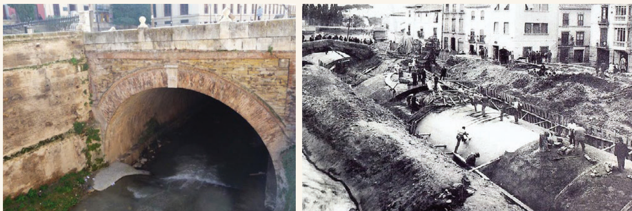
Abovedamiento del río Darro en Granada y trabajos del último tramo cubierto en los años 1936-38
