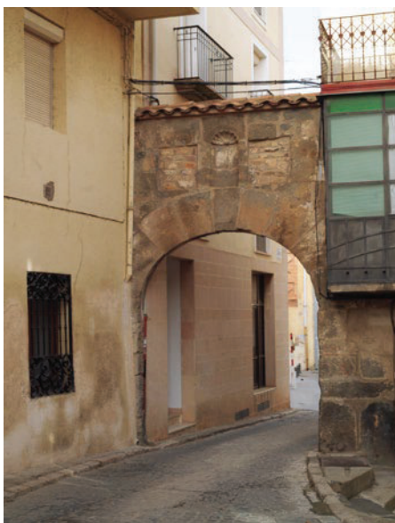
Puerta de Santo Domingo que daba cceso al puente.
