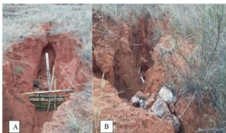
Figura 8 A/B - Paliçadas construídas dentro da fenda da ravina na região da Cachoeira da Serenata, município de Itambé do Mato Dentro (MG). A - Paliçada de bambu; B - Barramentos com blocos de quartzito e quartzo.
